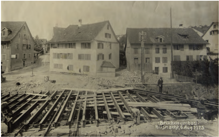
Brückenbau aus dem Jahre 1925
